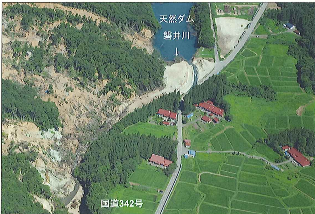
本復旧着手前(平成20年8月撮影)
