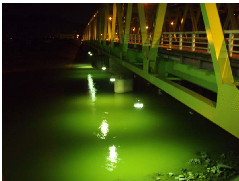
写真：国道4号 大仏橋（福島市舟場町）
