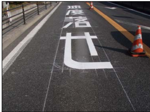
△路面標示(速度落せ)の事例
