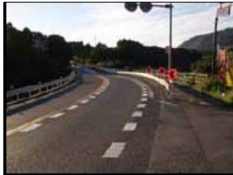
△高輝度路面標示(ドットライン)の事例
