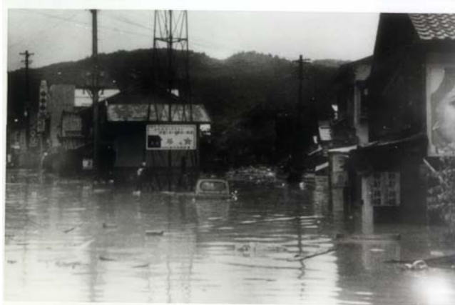
国道47号の冠水状況(戸沢村真柄)
