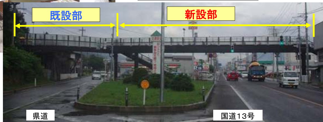
連結した横断歩道橋
