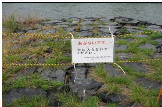
応急処置後 (立入禁止措置及び注意喚起看板を設置)
