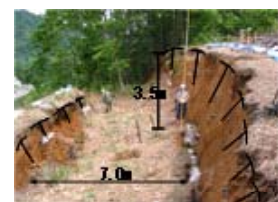
田麦俣地区地すべり頭部の陥没状況 (H16)
