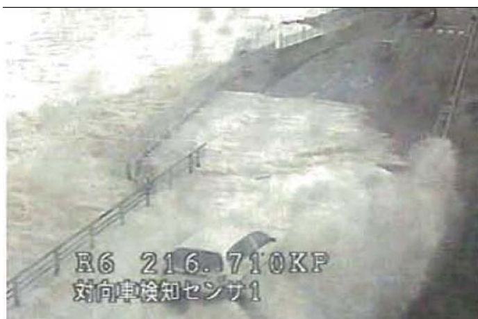
▲平成18年10月 越波状況
