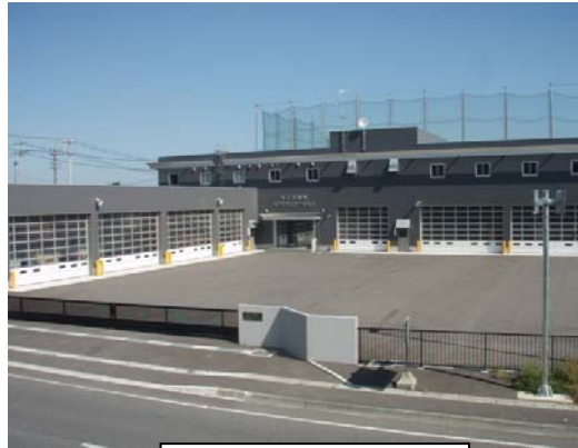
八戸防災ステーション全景
