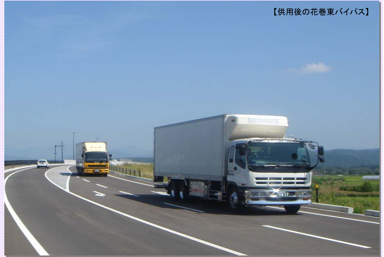
一般国道4号 花巻東バイパス
