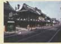
協議会活動助成、地区施設の整備修景、歴史的風致形成建造物の買取、復原
