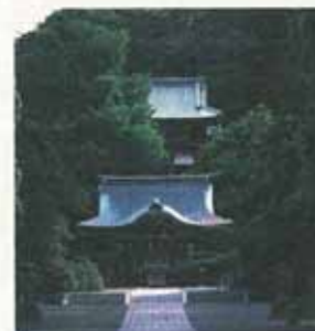
古都保存法により良好に保存される自然的環境(神奈川県鎌倉市)
