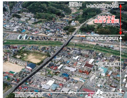
▲供用箇所全景
