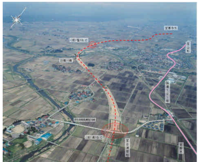
工事中の会津縦貫北道路
