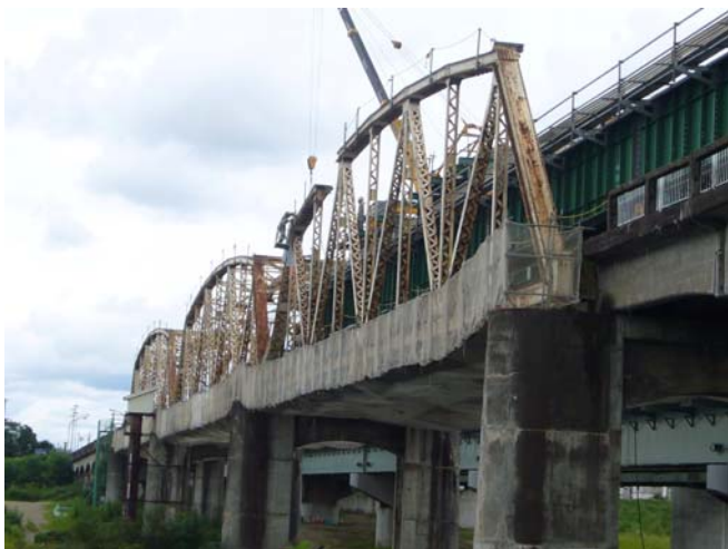
玉川橋旧橋撤去工事状況
