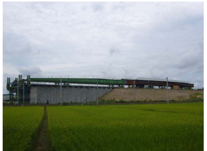
大浦跨線橋上部工工事状況
