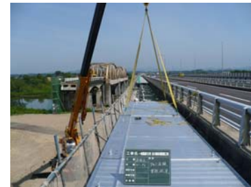
アルミ床板の設置状況
