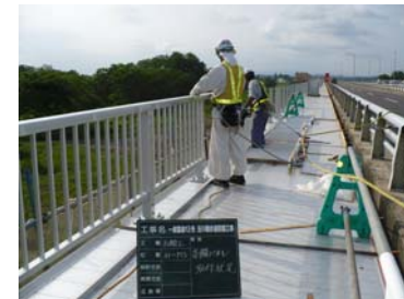
高欄の設置状況
