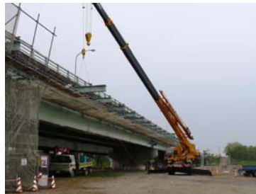
ブラケットの設置状況
