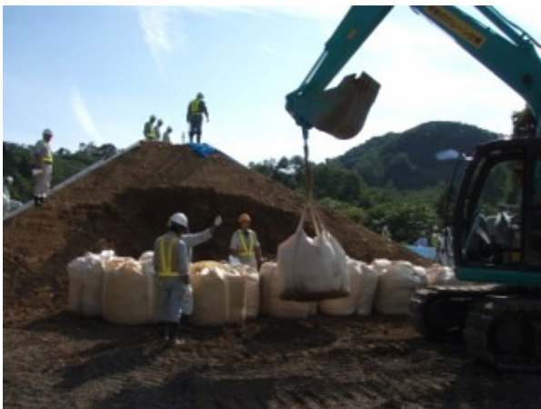
大型土のうを実践
