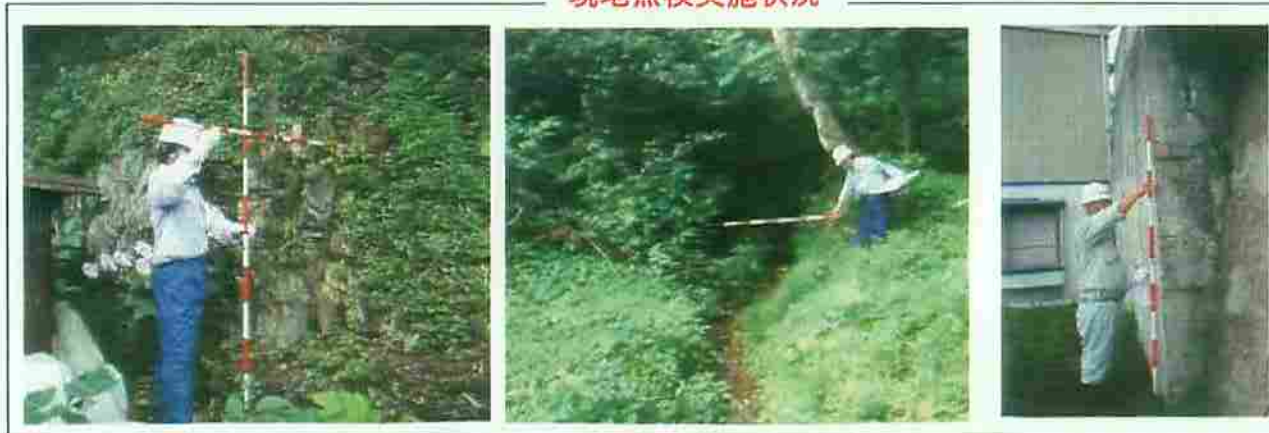
現地点検実施状況
