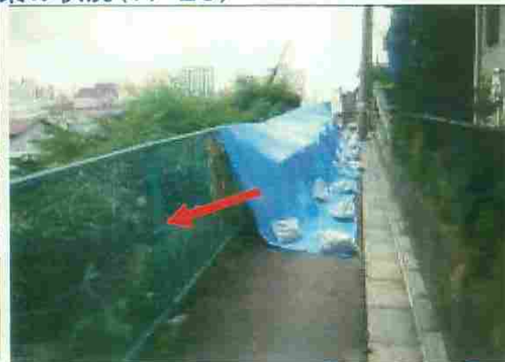
亀裂箇所における雨水浸透防止のためのシート張り
