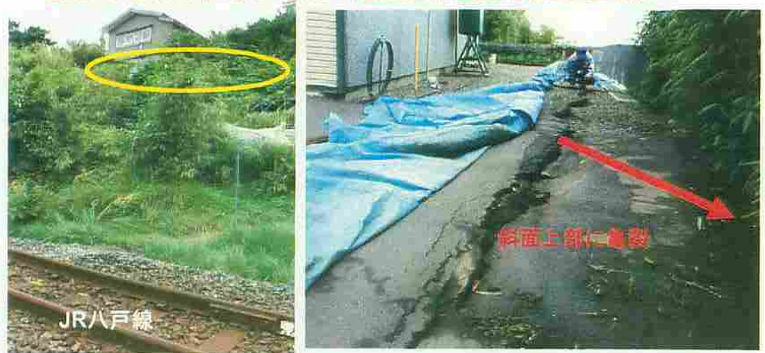
亀裂箇所における雨水浸透防止のためのシート張り
