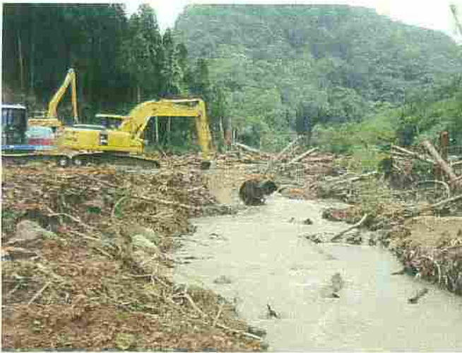
7月10日撮影 沼倉地区 河道掘削
