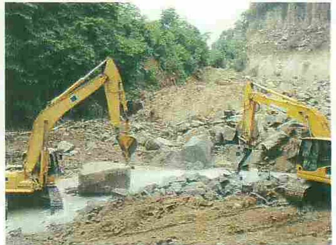
7月10日撮影 沼倉裏沢地区 河道掘削
