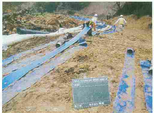
7月9日撮影 湯ノ倉温泉地区 排水ポンプ配管及び排水状況
