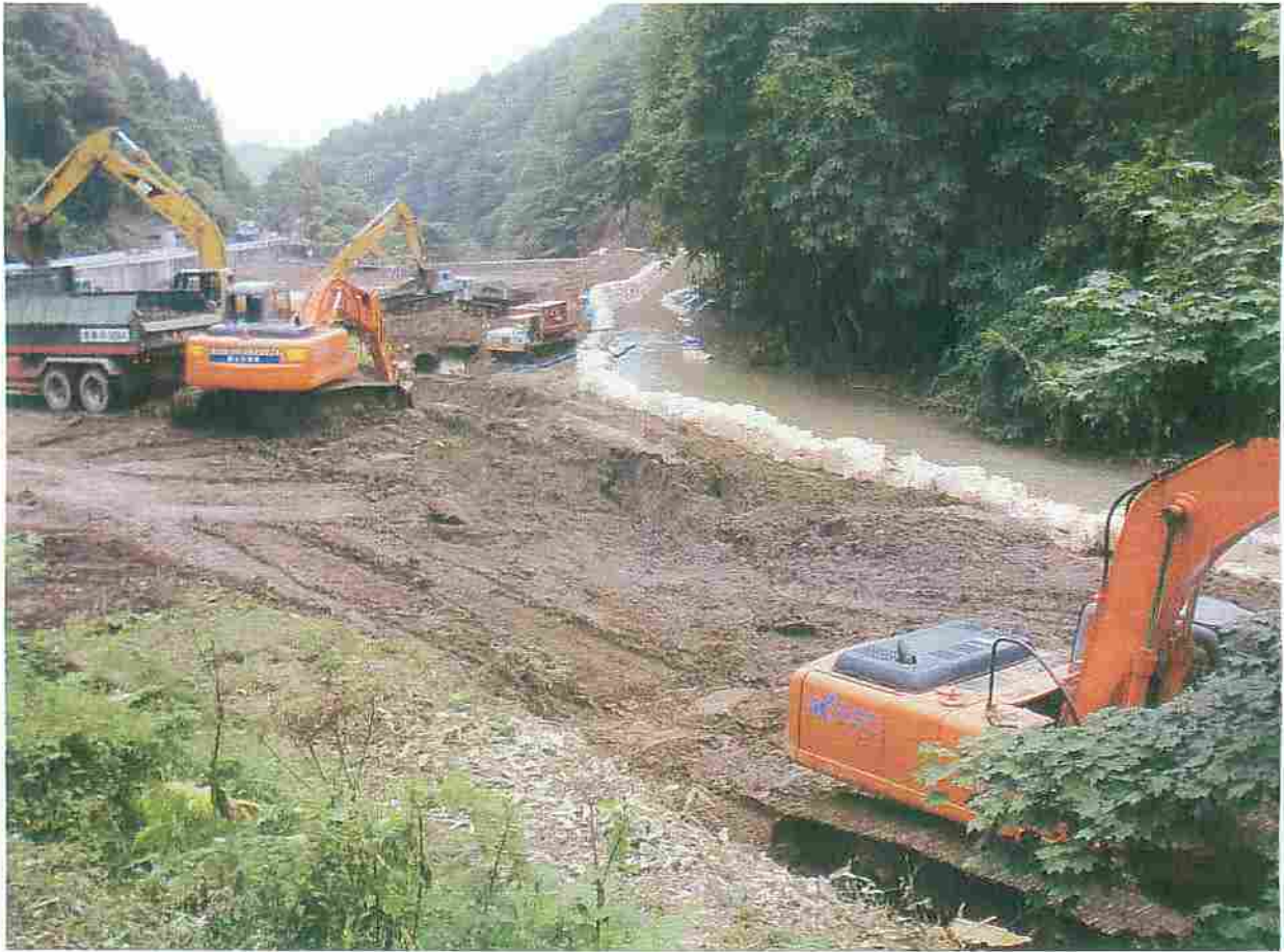
7月9日撮影 産女川地区 除石掘削運搬
