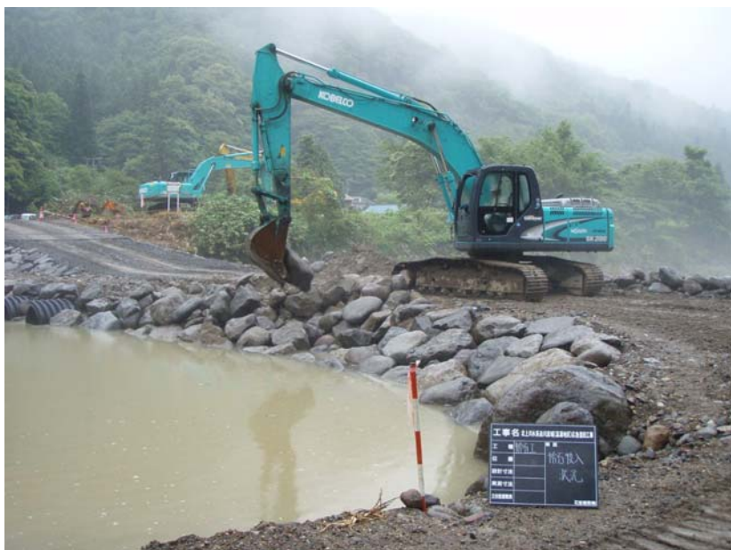
7月8日撮影 温湯地区 工事用道路造成
