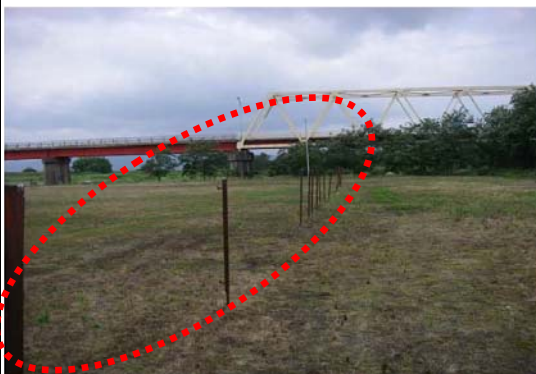
不要な鉄製ポールの存置
