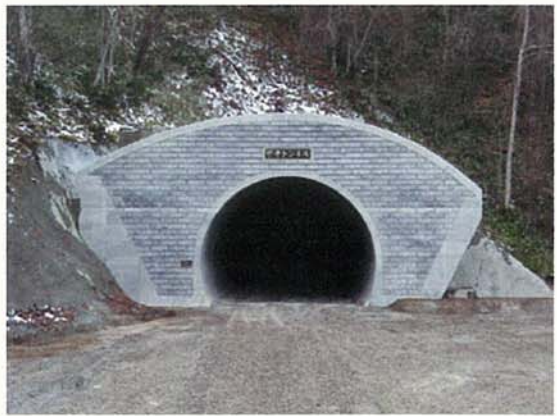
▲供用に向け工事が進む甲子道路
