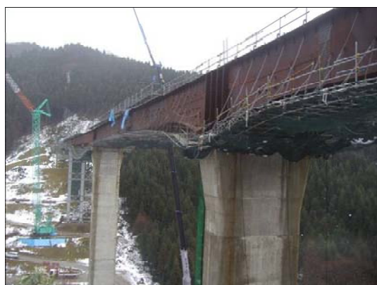
▲橋桁が繋がった大川目沢橋(平成19年12月)
