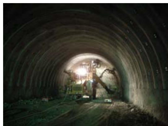
▲施工中の大茂内第二トンネル(平成20年1月)
