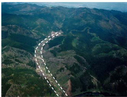
▲北秋田市栄地区から大館市方向を望む (平成19年5月)
