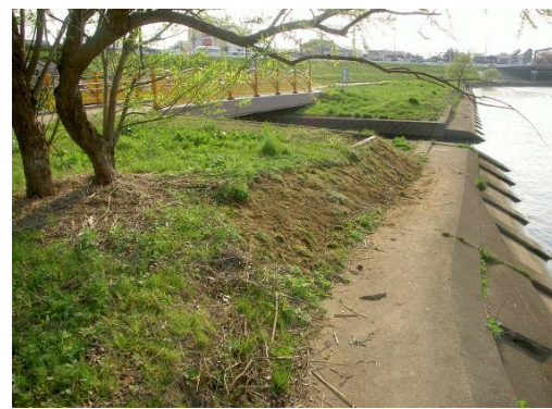
土砂埋めによる補修
