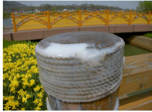
破損部の補修、ロープの巻き直し
