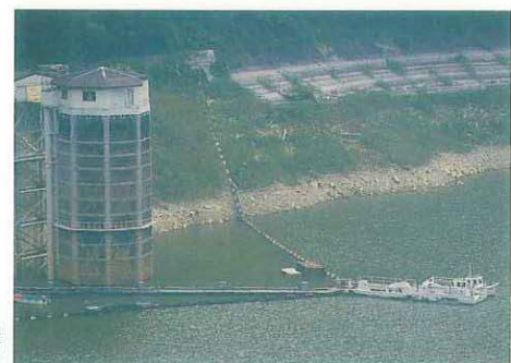
取水塔(ダム上流右岸)
