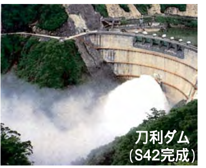
既設洪水調節施設
