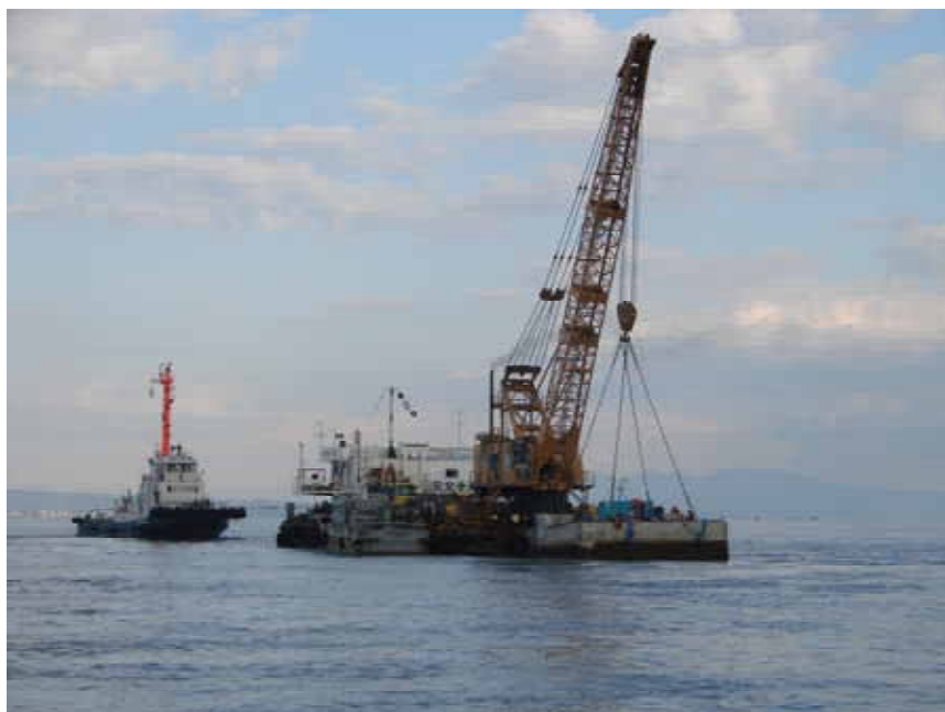
【ケーソン曳航の様子】
