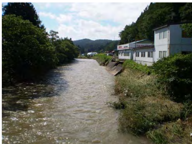
②一級河川 安比川(二戸市石橋地区内)
