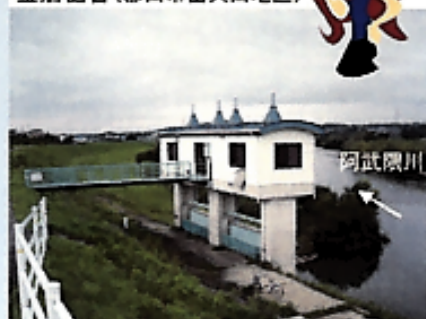
釜沼樋管(郡山市富久山地区)
