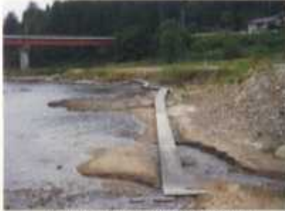
ウッドデッキ歩道の状況
