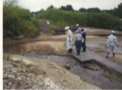
ウッドデッキ歩道上流端部及び 蔦沢川飛び石付近土砂堆積
