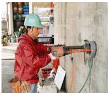
(写真左) 小径コア採取状況
