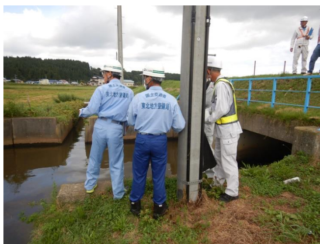
排水樋門の点検状況
