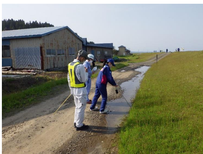
堤防の点検状況
