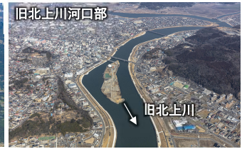
復旧・復興事業が完了した旧北上川
