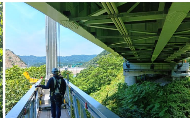
橋梁点検車による点検状況
