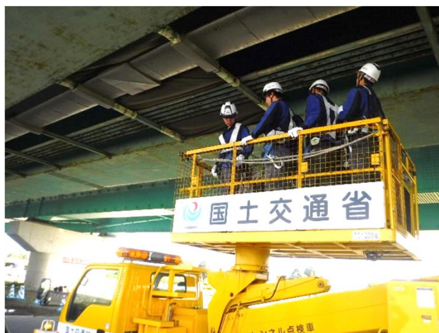
▲高所作業車搭乗による近接目視
