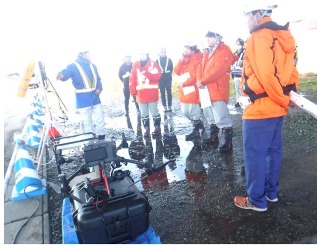
▲無人航空機(マルチコプター)を利用した橋梁点検システム
