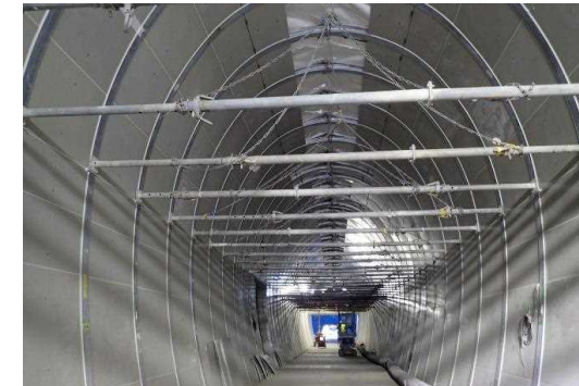
③JRトンネル本体補強施工状況
