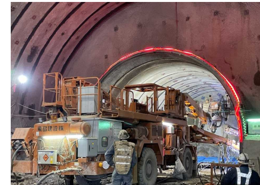
⑤JR近接部先進導坑 地山補強状況
