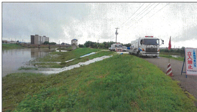
平成29年7月豪雨 福部内川での排水作業
