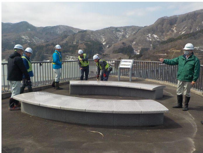
占有者との点検(津軽ダムパーク)
