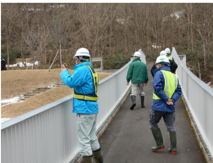
占有者との点検(白神が故郷橋パーク)
