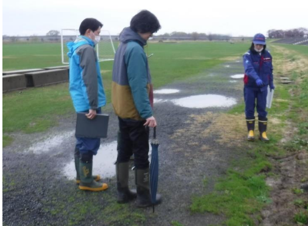
点検状況(北斗グラウンド)
