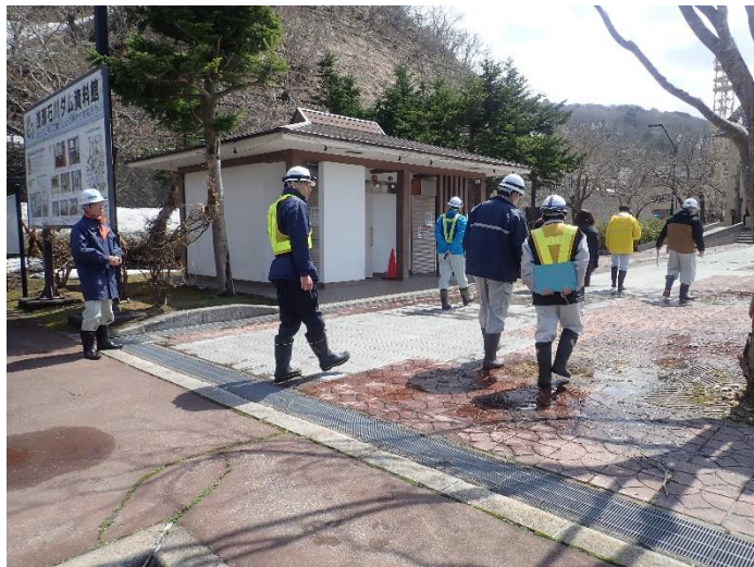
占有者との点検(ダムサイト公園)
