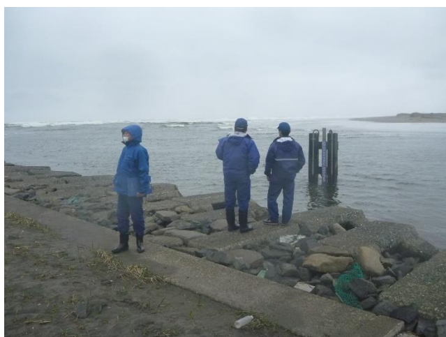
点検状況(高瀬川河口)
