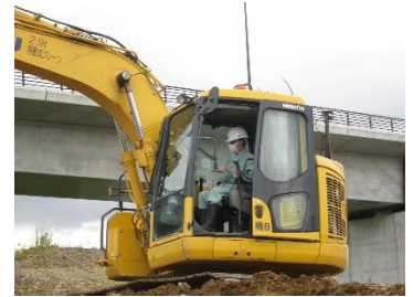
▲ICT建機搭乗体験(築堤工事)
