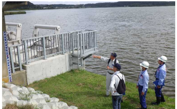
排水樋門の点検状況
