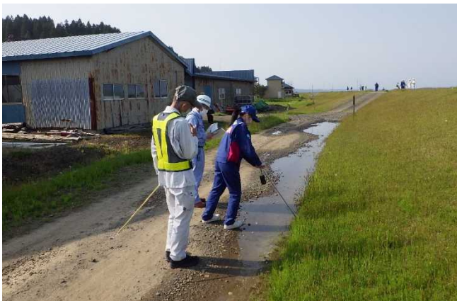
堤防の点検状況
