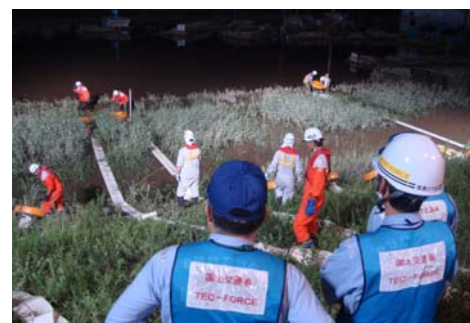
▲ 排水ポンプ車による排水活動
