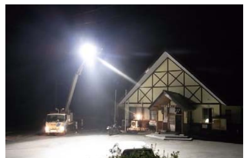
▲ 避難所への照明車設置
