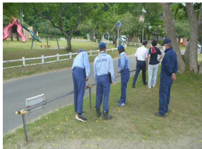
点検状況(三沢湖水浴場)
