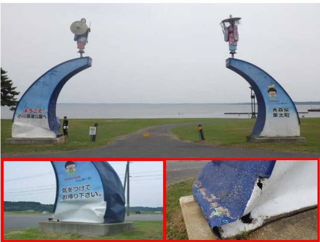
点検状況(小川原湖公園)
