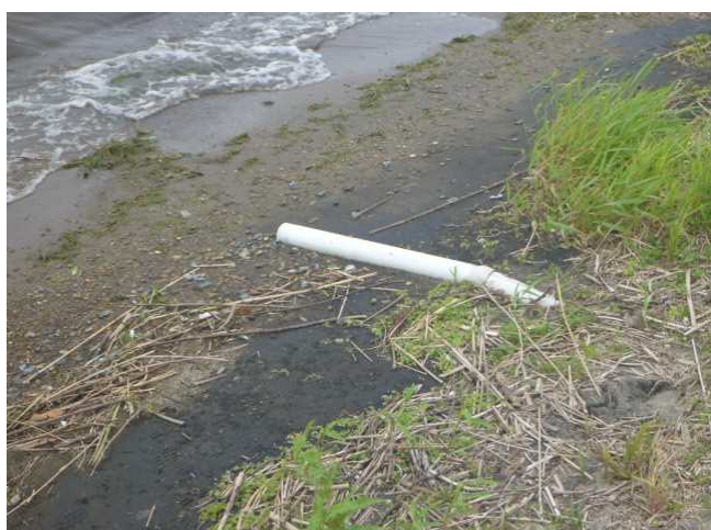
点検状況(三沢湖水浴場)
