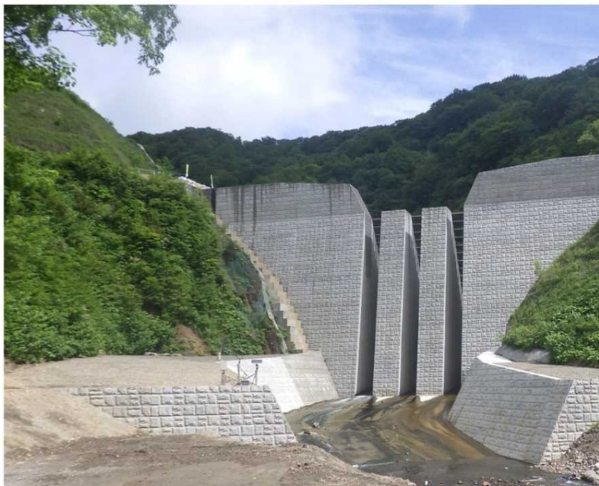
会場:シガクラ沢砂防堰堤 (下鹿倉橋付近)
