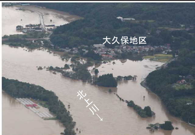
▲平成14年7月出水による被害状況
