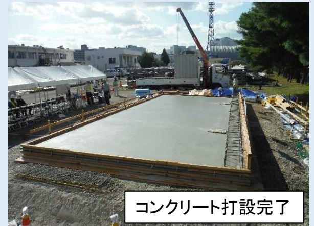
コンクリート打設状況
