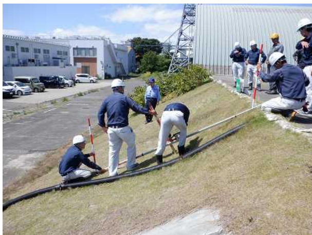
堤防のはらみ出し・寺勾配の計測
