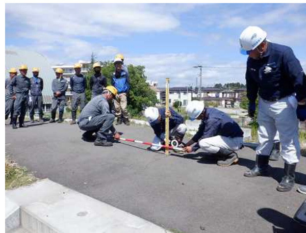
堤防の抜け上がりの計測
