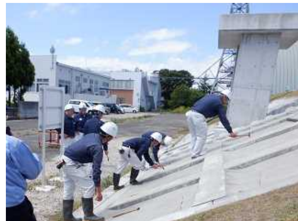
打音による護岸の空洞化の確認
