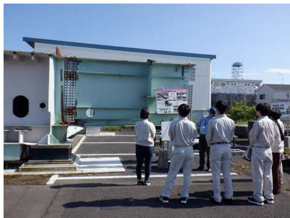
橋梁上部工(被災した鋼製箱桁)について
