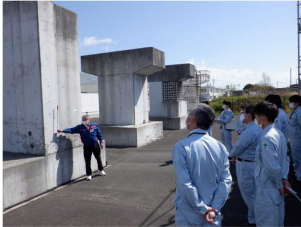
不適切施工について
