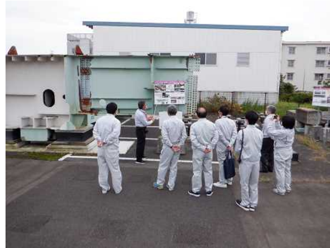
被災した鋼箱桁について
