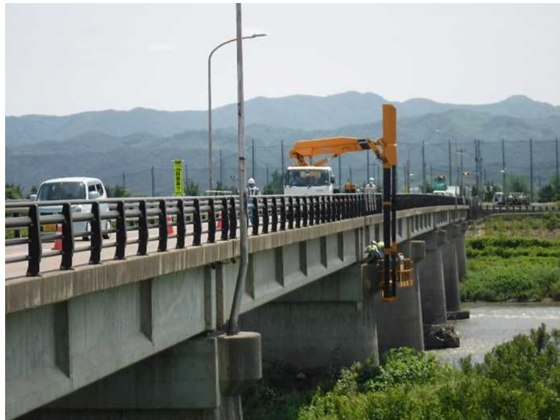
5月30日 橋梁点検車による損傷状況の確認状況(東北地方整備局、東北技術事務所)
