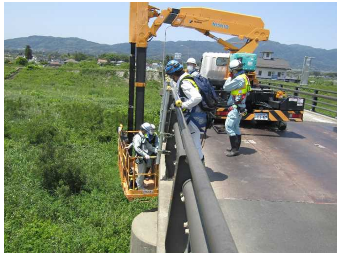
5月30日 橋梁点検車による損傷状況の確認状況(東北地方整備局、東北技術事務所)
