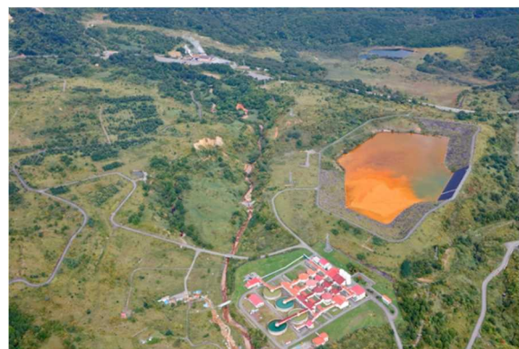
（写真-2 旧松尾鉦山新中和処理施設）
